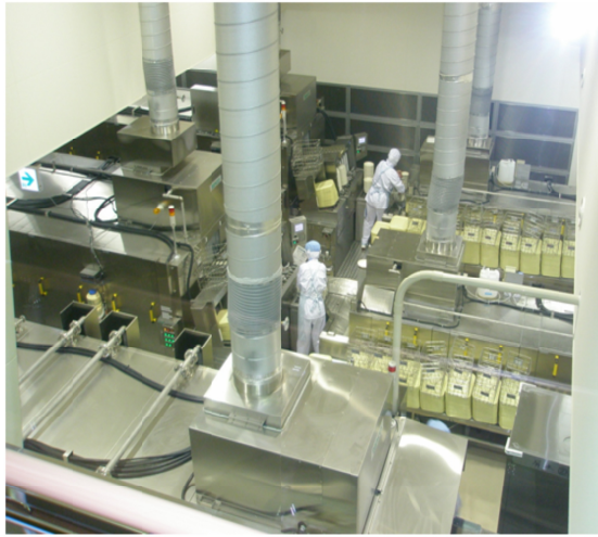
久留米市中央学校給食共同調理場の内部
