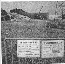
造成工事中の4市施設予定地
