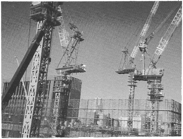
東京中央区勝どき地域の再開発現場
