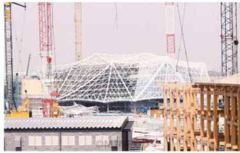
建設中の大阪関西万博会場
